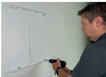
2. Löcher Bohren & Montagebügel befestigen
