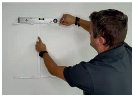
1. Montagebügel dient als Bohrschablone
