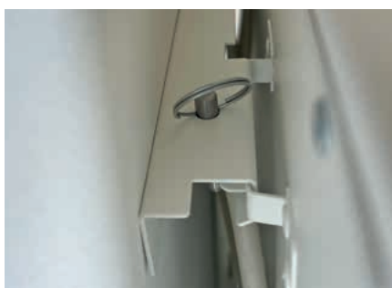
5. Sicherungssplints setzen
