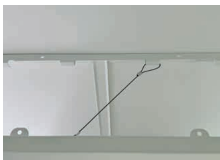
4. Sicherungsseil einhaken & Paneel anschließen
